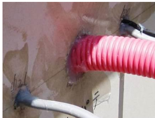
写真-2 加熱前ケーブル状況
