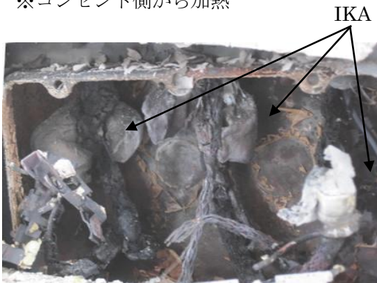
写真-5 60分加熱後コンセント状況 (加熱側)
