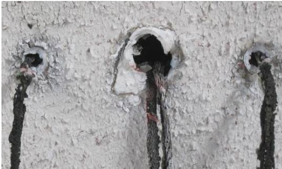
写真-3 60分加熱後ケーブル状況 (加熱側)
