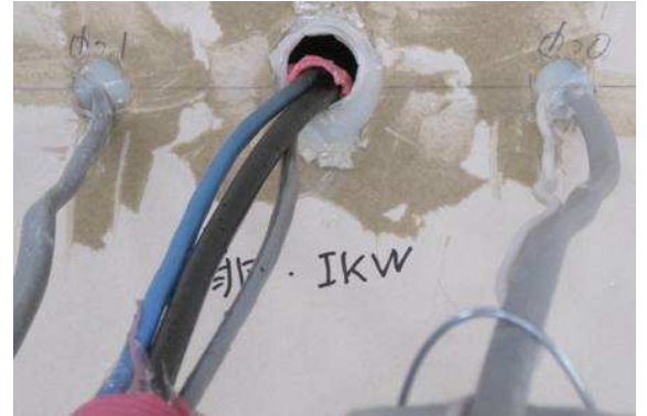
写真-9 電線管内ケーブル解体状況 (非加熱側)
