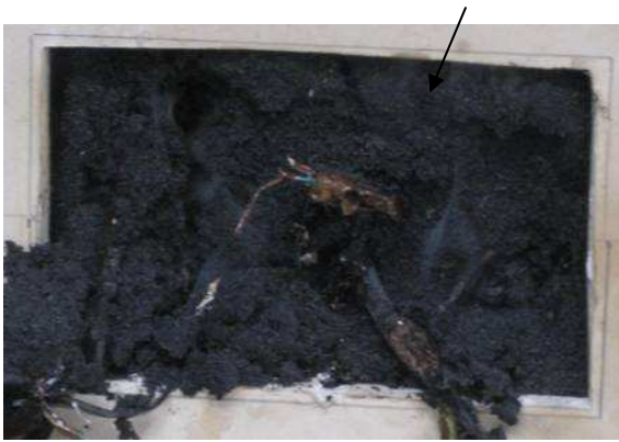
写真-8 コンセント解体状況 (非加熱側)
