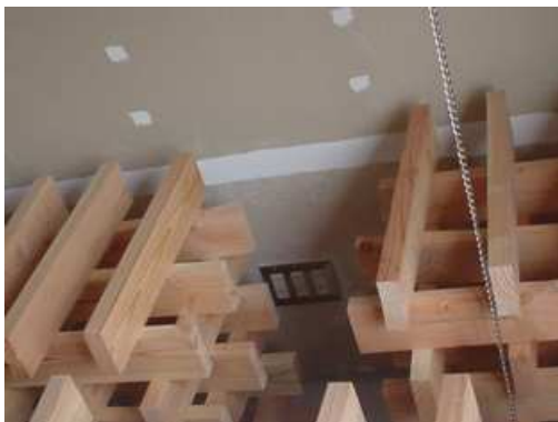
コンセント設置状況
