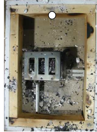
写真-3 加熱後壁内状況
