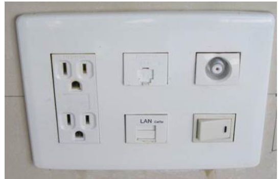
写真-4 コンセント側状況 (非加熱側)
