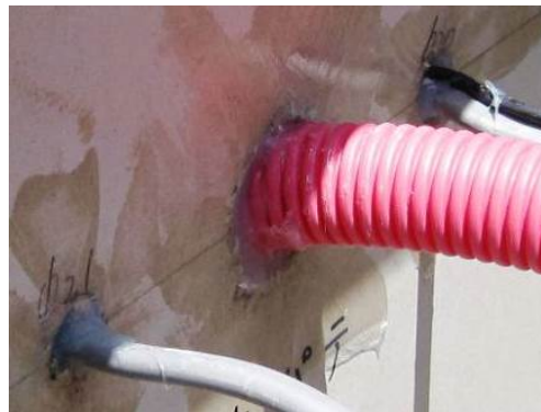
写真-2 加熱前ケーブル状況
