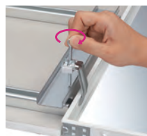
③ハンガーボルトを数回回し 締めつけ固定
