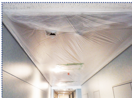
照明器具・天井埋込型エアコン等の取替
