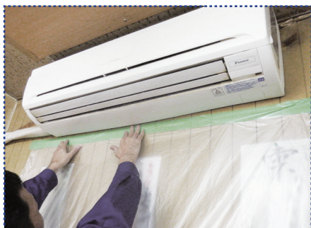
エアコンの取替・清掃
