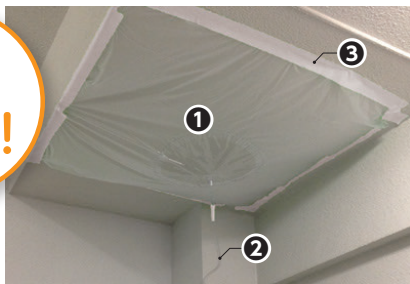
水漏れ箇所に合わせて「①専用シート」と「②専用ホース」をセットし、「③専用テープ」で固定します。
