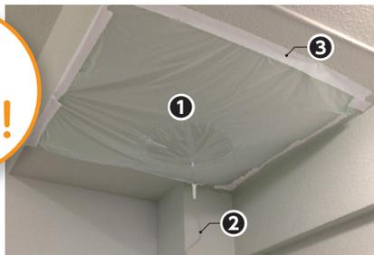
水漏れ箇所に合わせて「①専用シート」と「②専用ホース」をセットし、「③専用テープ」で固定します。
