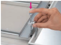
②ハンガーボルトを取付野縁に当たるところまで押し込む
