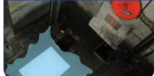
エレベーターピット
