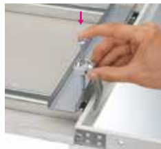
②ハンガーボルトを取付野縁に当たるところまで押し込む
