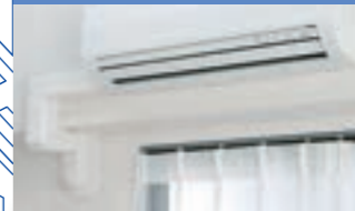
家庭用エアコン
