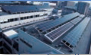
太陽光発電システム
