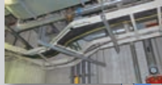
電線ケーブル類
