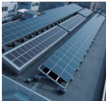
太陽光発電システム
