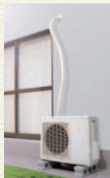
従来のテープ巻きによる配管
