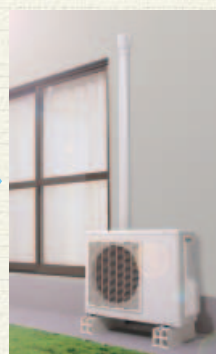
スリムダクトSDによる配管
