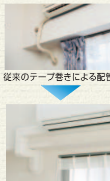
スリムダクトMDによる屋内施工例
